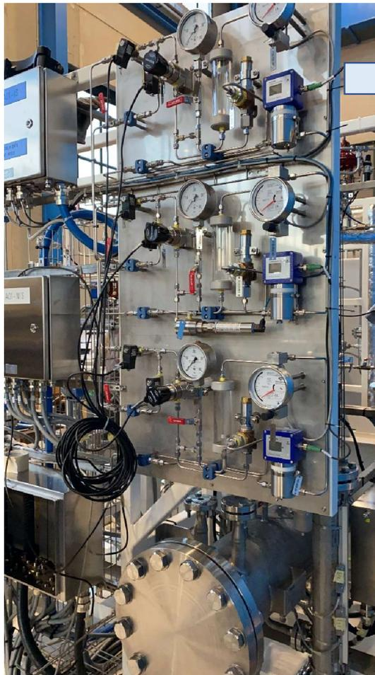
*Pannello di analisi installato a bordo di un elettrolizzatore alcalino:*
