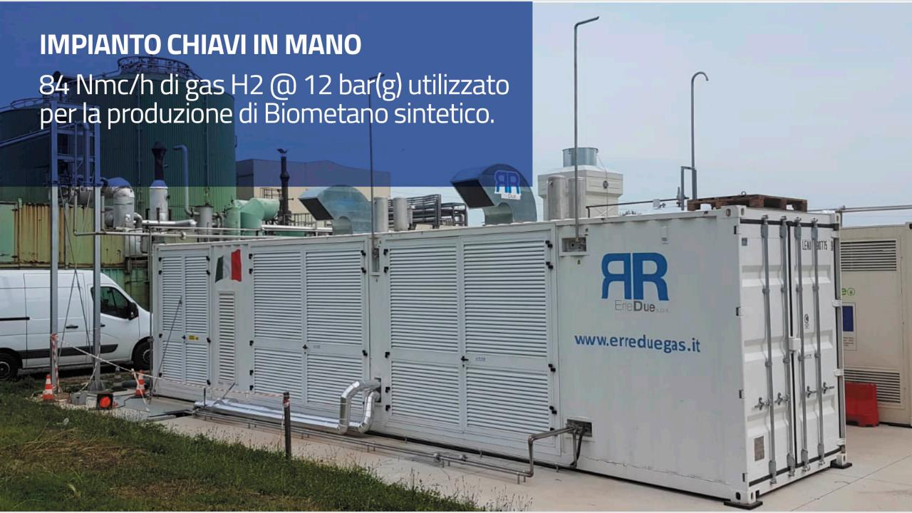
GENERATORE DI IDROGENO MERCURY Installazione di un generatore di idrogeno "Mercury G1" in container Plug&Play, per lo studio di ottimizzazione dei processi di biometanazione.
